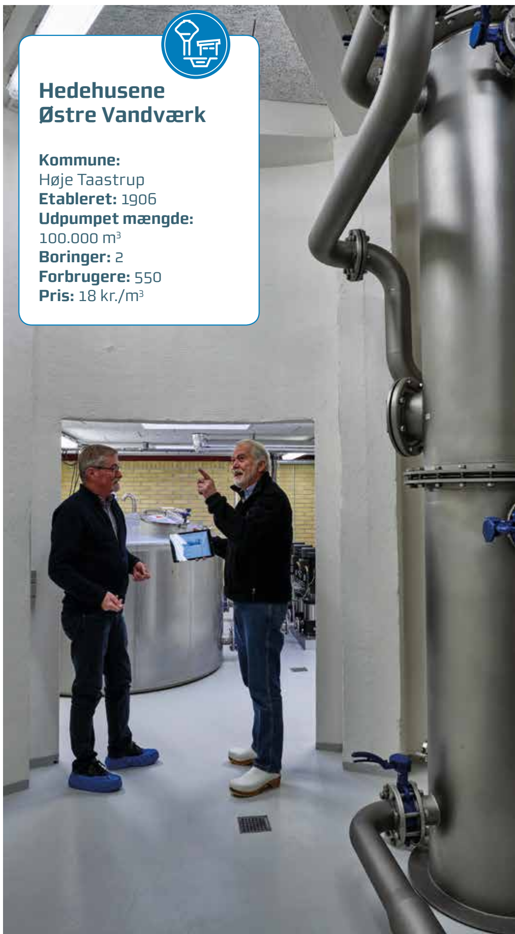
Karsten Skydegaard (tv.) og Poul-Henrik Larsen i det topmoderne vandværk. I det gamle vandtårn står de to beluftningssøjler.
